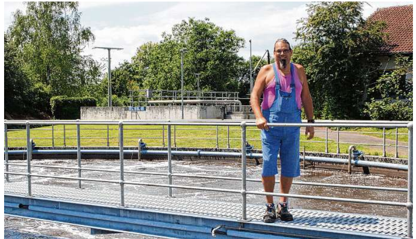
Die Salemer Kläranlage in Buggensegel ist an ihre Kapazitätsgrenzen gestoßen. Seit ihrer Inbetriebnahme im Jahr 1991 ist Peter Godau Leiter der Anlage. BILD: PETER SCHOBER
