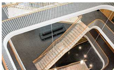
Die Kostenabrechnung für das neue Rathaus und die Tiefgarage liegt vor: insgesamt 18,1 Millionen Euro. Ist das zu viel für Salem? Darüber gibt es unter den Gemeinderäten unterschiedliche Meinungen. BILD: PETER SCHÖBER
