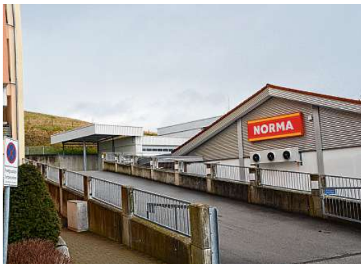
Wo heute noch die Gewerbehalle steht, soll hinter dem Discounter ein Ärztehaus gebaut werden. BILD: LORNA KOMM
