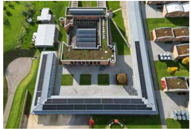
Die PV-Anlage auf den Dächern des Campus Härden produziert um die 160.000 Kilowattstunden Strom jährlich. Das entspricht dem Strombedarf von über 50 modernen Einfamilienhäusern.
